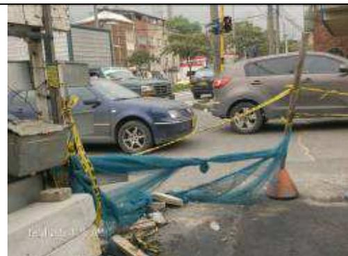
FOTO No 29: 22 Intersección de la Carrera 19B con la AC 28. La señalización de la obra es inadecuada, las colombinas están con palos. No se evidencia la cinta de señalización en los tres niveles de las colombinas. Las señales están soportadas sobre escombros. La polisombra está en pésimo estado
