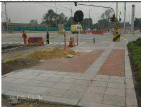
FOTO No 36 Intersección de la Carrera 19B con la AC 28. La señalización de la obra es inadecuada, las colombinas están con palos, no hay cinta de señalización, la polisombra está en pésimo estado y las señales están soportadas sobre escombros.
